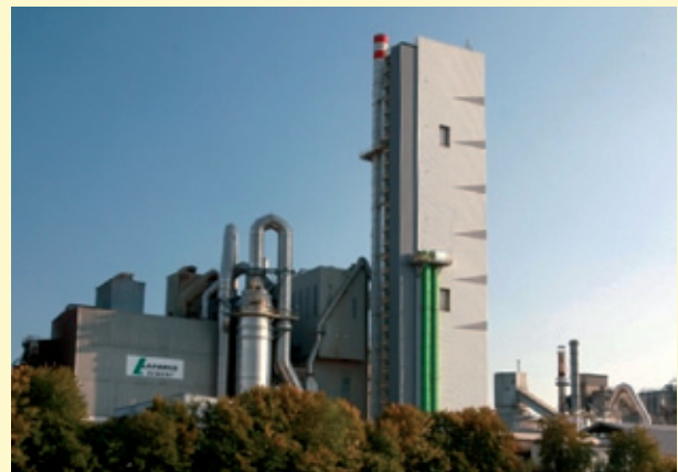
Bild: Lafarge Zement Wössingen GmbH
